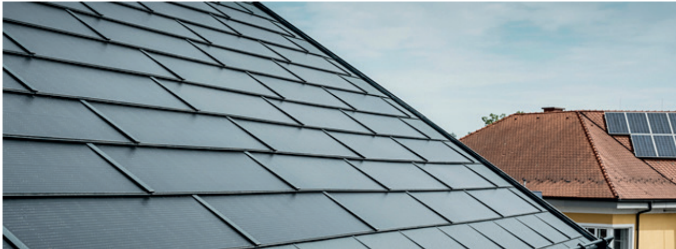
Foto: Vergleich PREFA voll integrierte PV-Dachplatten (links) mit klassischen Dach PV-Modulen (rechts).
